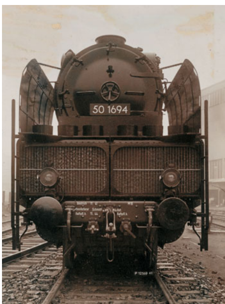
Stirnansicht der 50 1694 mit den beiden Schlangenrohrkühlern zur Unsichtbarmachung des Abdampfes. | WERKFOTO KRUPP/SLG. ASMUS
