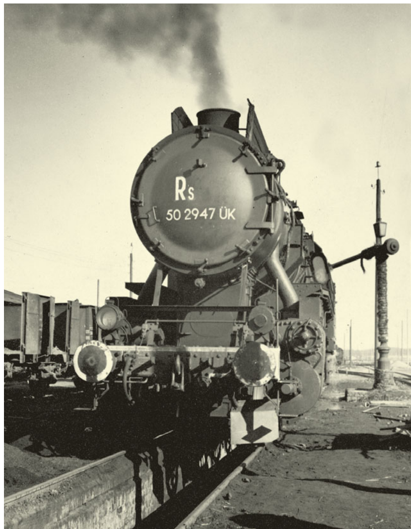
50 2947 ÜK mit nachträglich angebrachter hölzerner Windleitvorrichtung auf der Rauchkammer im besetzten Baltikum beim Wassernehmen. F. KORTE/ARCHIV SCHULZ
