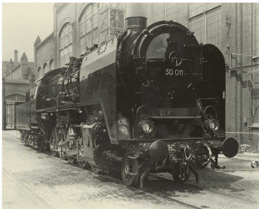
50 011 wurde ab Werk für Braunkohlenfeuerung und mit Waikato-Funkenfänger ausgerüstet. Die Lok wurde am 24. Juni 1939 abgeliefert und absolvierte zusammen mit der 50 012 ausgedehnte Versuchsfahrten, ehe sie ab August 1939 für den regulären Betriebsdienst zur Verfügung stand. | WERKFOTOS HENSCHEL/SLG. GUMBERT (2)
