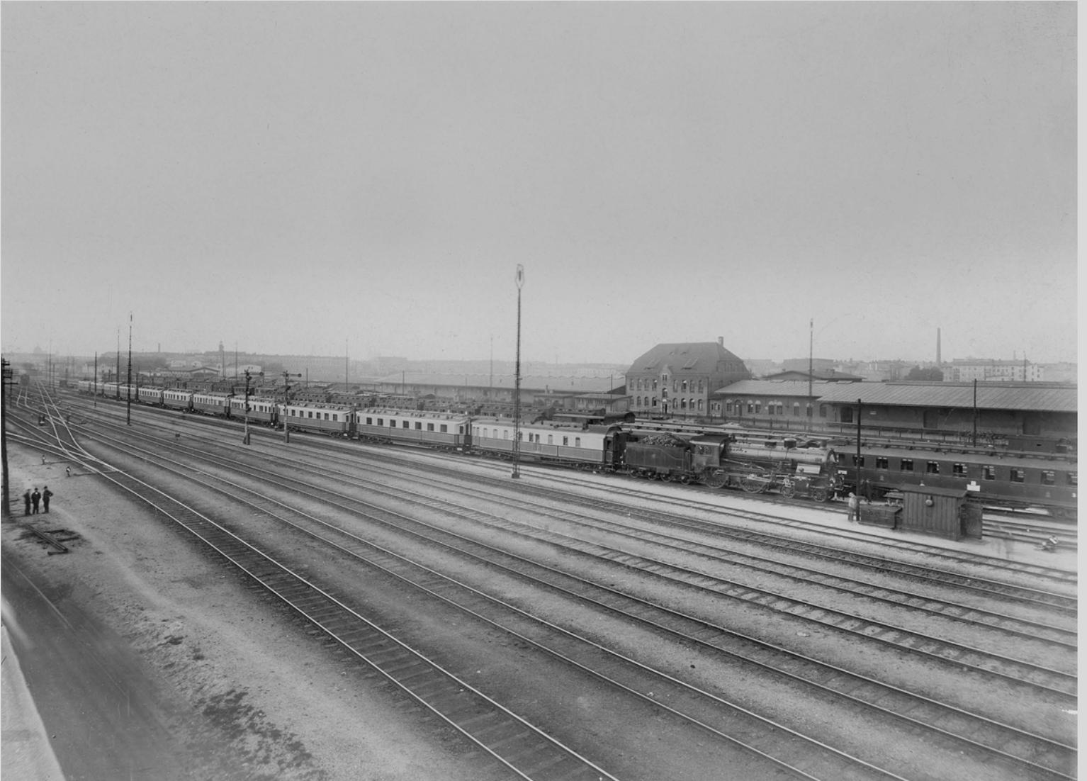
Der hier mit elf Wagen konfigurierte Hofzug war dem Hersteller Linke-Hofmann ein Foto wert, stammten doch alle Fahrzeuge einschließlich der preußischen S 6 als Zuglok aus dem eigenen Betrieb in Breslau. Die nur zweifach gekuppelte Lokomotive hätte aber mit dieser schweren Garnitur große Mühe gehabt
