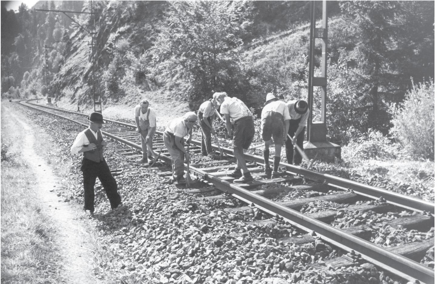
Die Erhaltung des Oberbaus ist bis in die heutigen Tage sehr arbeitsintensiv. Das Bild zeigt einen Gleisbautrupp beim sogenannten Stopfen (Verdichten des Gleisschotter). Warnwesten waren damals noch unbekannt.
