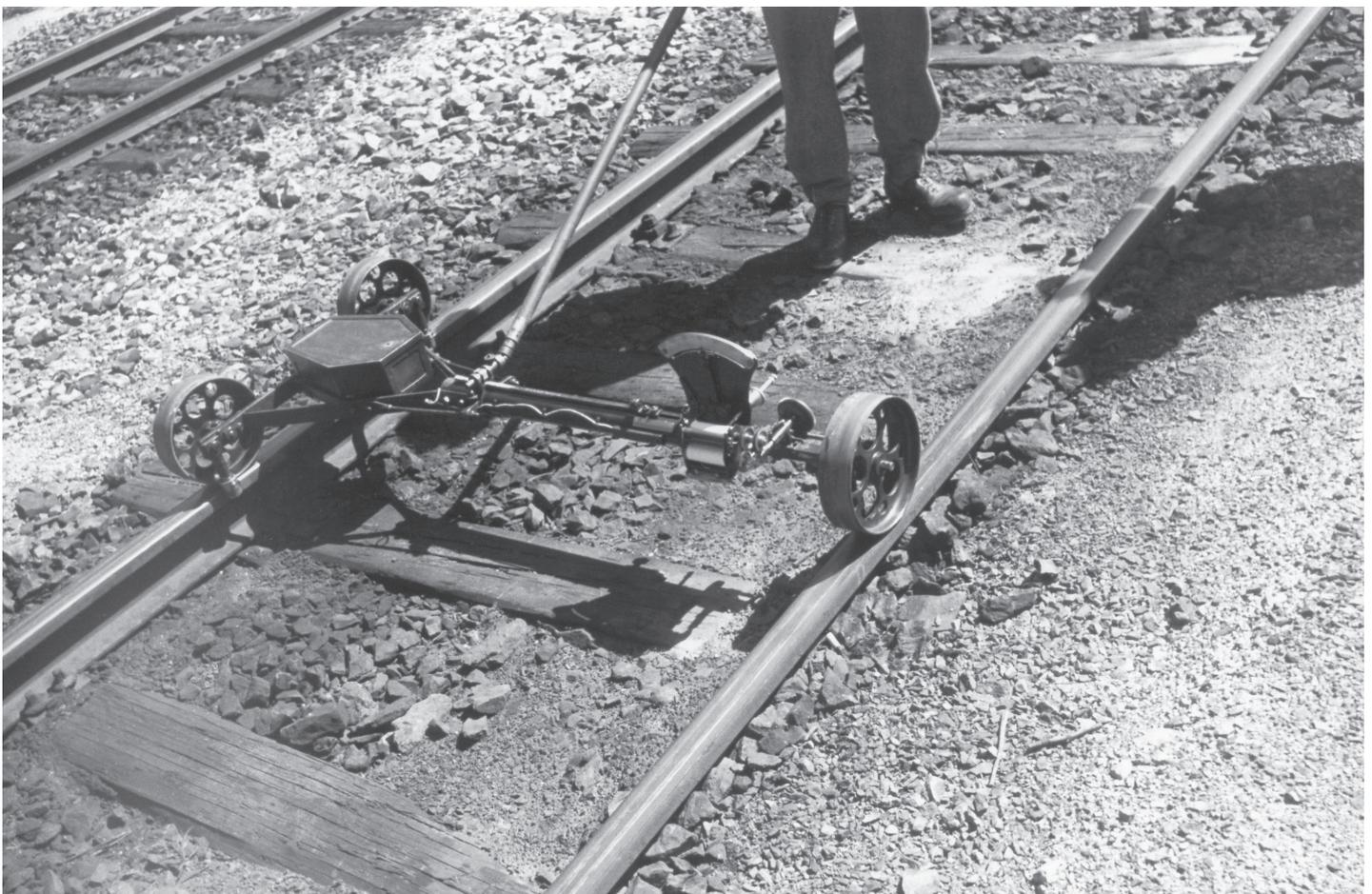
Sehenswert auch das Gerät zum Prüfen der Schienenabstände mit dem der Gleismeister und dessen Untergebene die nötigen Prüfungen durchführten.
