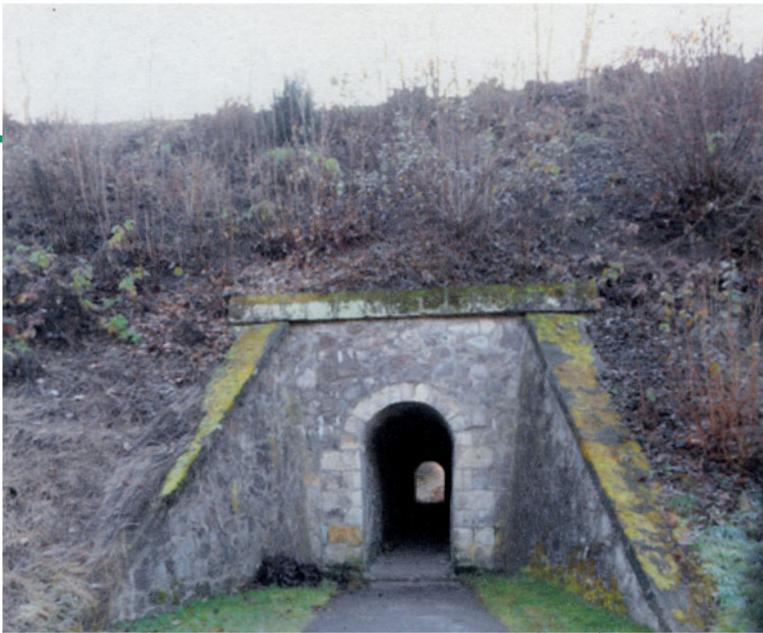
Sandsteingewölbedurchlass des Geyersgrabens bei Km. 2,244: Die Kohlenbahn führt über den massiven Schüttdamm von der Talstation aus in homogenen Neigungen 1:40 zum Obergittersee-Passplateau empor. Der Durchlass wurde entsprechend dem aufsteigenden Grabenprofil, für die öffentliche Nutzung auf seiner gesamten Durchführungslänge konisch ausgebaut.
