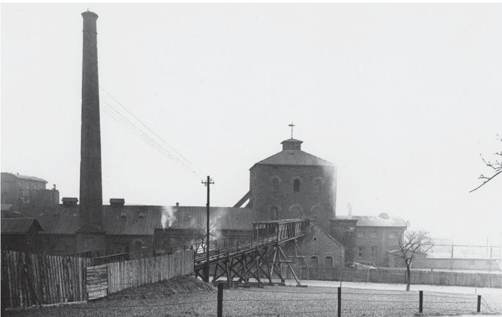
Die hölzerne Brückenrampe der Drahtseilbahn/Kettenbahn zum Marienschacht überspannt die Kohlenstraße, bevor die Gleisbahn im Horkenbergtunnel verschwindet. Die Seilbahn transportierte ab 1927 nach Einstellung der Marienschachtwäsche ihre gesamte Förderung zum Glück-Auf-Schacht, ab 1906/07 zur modernisierten und erweiterten Zentralwäsche.
