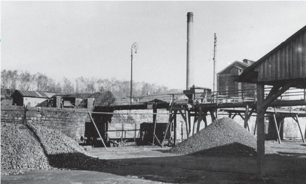
An der Lademauer des Gleises II hat das Ladehofpersonal einen DRG-O-Wagen (Ommk(u)) mit dem Zugseil unter die Schüttbrücke mit Rolltrichter zur Beladung gezogen.
